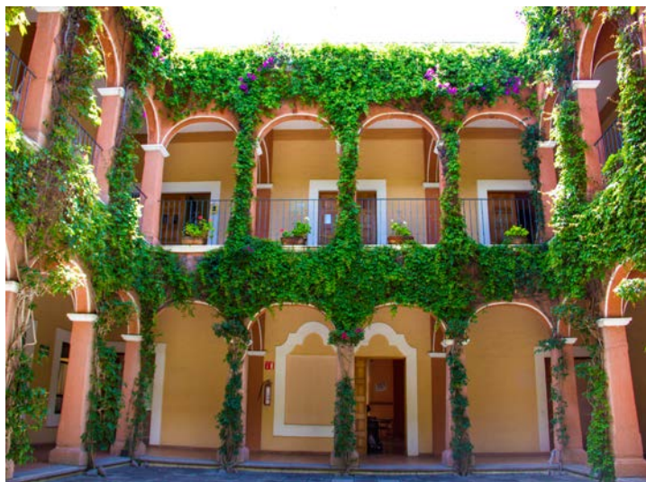
Claustro del patio interior de las aulas
